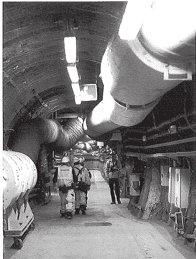
Situé à la limite de la Meuse et de la Haute-Marne, le laboratoire souterrain de Bure préfigure à 500 mètres sous terre le futur centre de stockage de déchets nucléaires. Photo archives AFP
