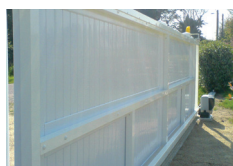
Cadre ossature en aluminium pour portail PVC laqué en blanc
