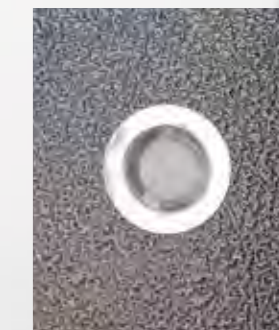
Insertion de leds dans les poteaux
