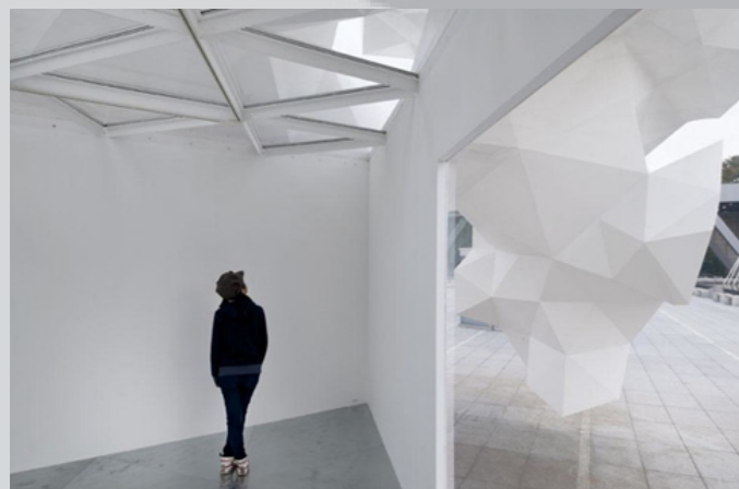
Vue intérieure - reprise des triangles par une structure évidée
