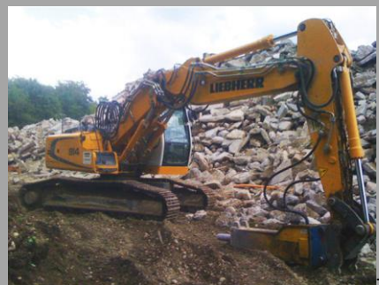
DEMOLITION AU BRH ET PINCE SUR PELLE 914 A CHENILLES
