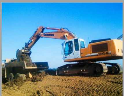
TERRASSEMENT SUR PELLE 944 A CHENILLES
