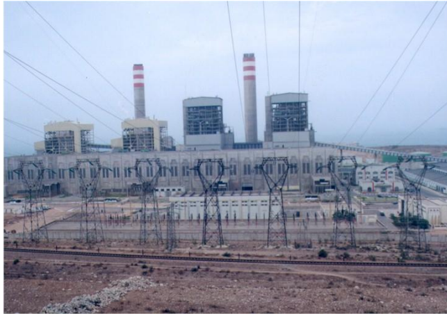
Centrale thermique de Jorf Lasfar
