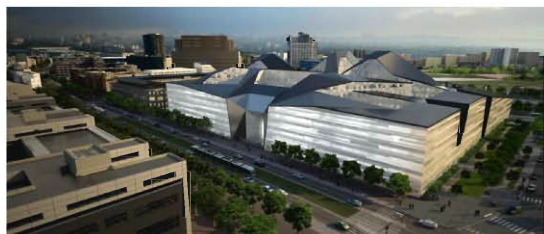
La mairie a déposé hier un recours devant le tribunal administratif contre le permis de construire délivré par l'Etat pour le ministère de la Défense en construction à Balard (XV e ). (ARTEFACTORY)
